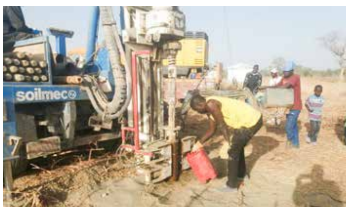
La costruzione di un pozzo d'acqua in Camerun
